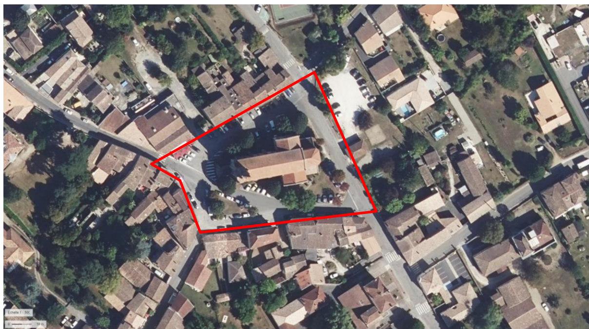
Carte 2 : Vue aérienne sur la place Aristide Briand en 2021 (avant travaux de requalification)
