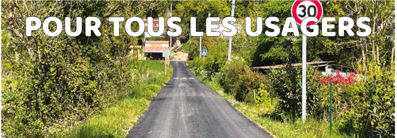
La voirie du chemin de Bigueresse a été refaite à neuf.
