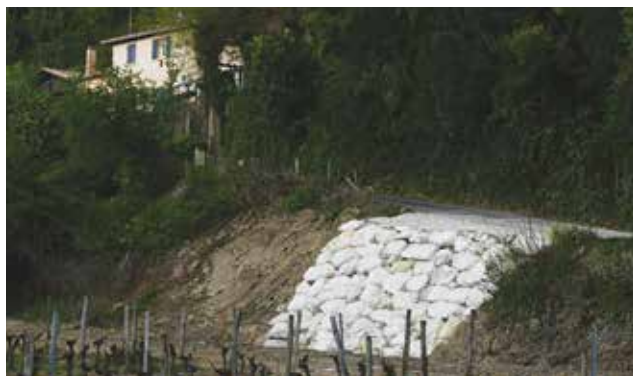
Enrochement chemin de Peyreplate.
