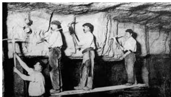
Exploitation des carrières pour extraire la pierre bordelaise (source EPRCF33)
