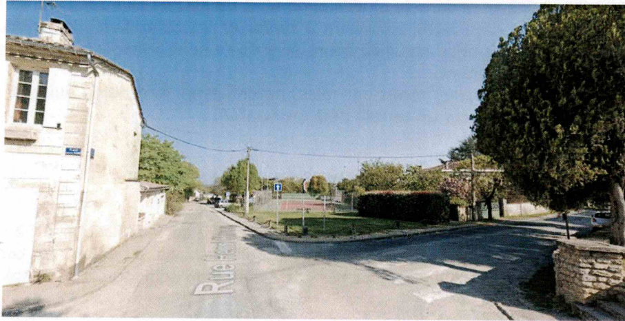
Vue sur le site de projet depuis l'espace de stationnement à l'Est de la place Aristide Briand
